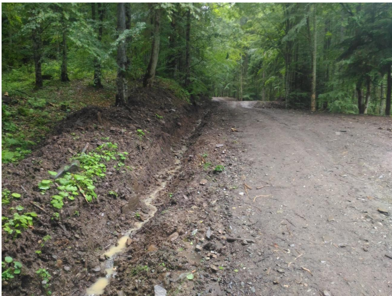
Figură 10 - Aspect din traseul drumurilor forestiere actuale (foto: Neațu Sabin)
