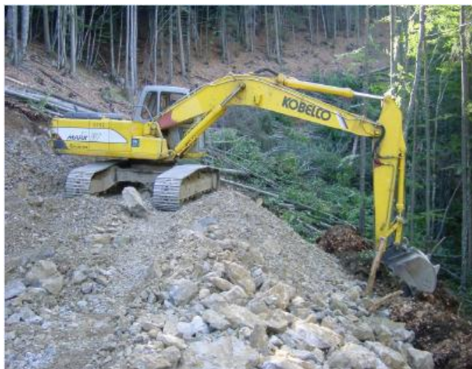
Fig.4 Excavator în lucru, cf. Ghidului de bune practici pentru drumuri forestiere
