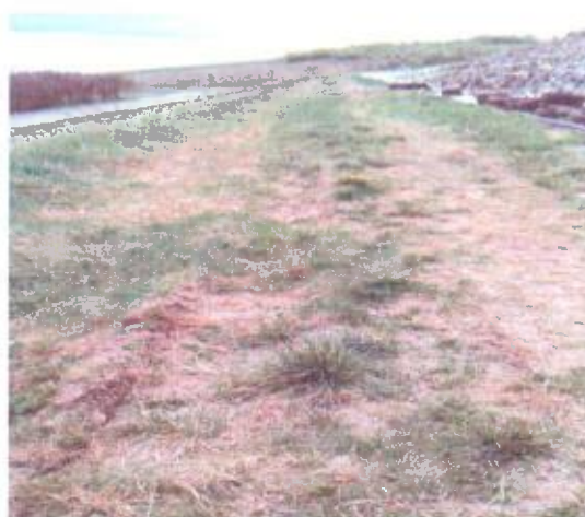
Fig. 8 – Dig Est – partea de sus
