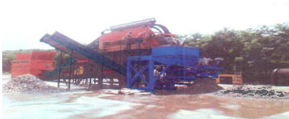
Fig. 15 – Instalatia separare mecanica
