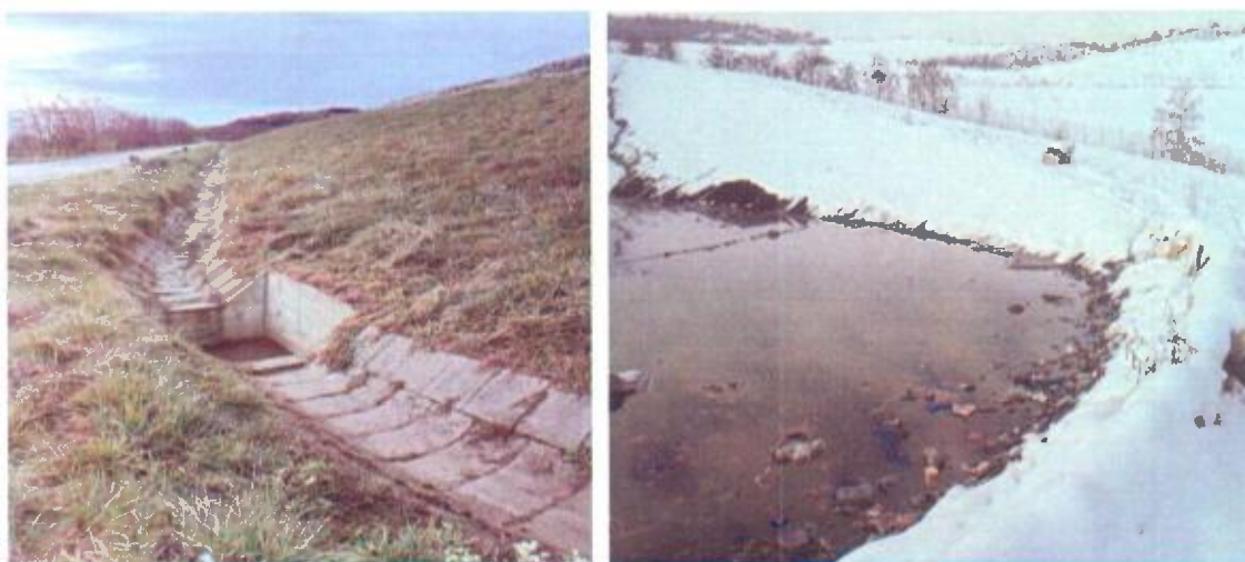
Fig. 9 – Canal garda celula 1 – si acumulara din colt NE
