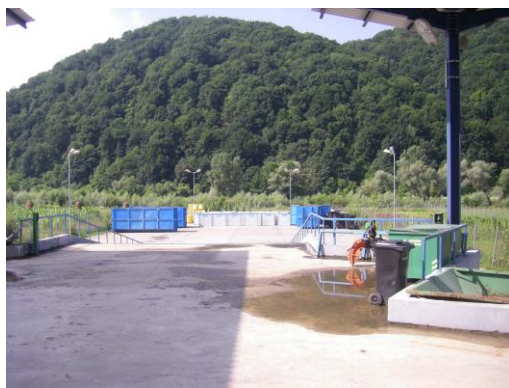
(Stația de Transfer Năsăud)
