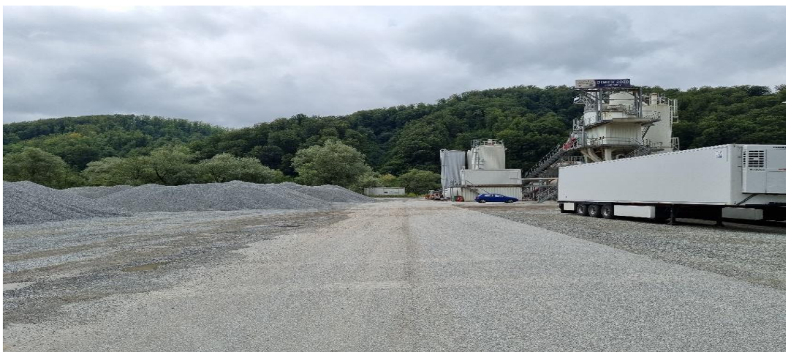
Fig. 14. Platformă de sortare și mixare de agregate minerale din localitatea Nepos, aflată chiar pe malul Someșului, la limita ariei protejate, față de care nu există niciun fel de zonă tampon, fiind înlăturată inclusiv vegetația arbustivă de pe mal. Foto: Gabriel Vânău
